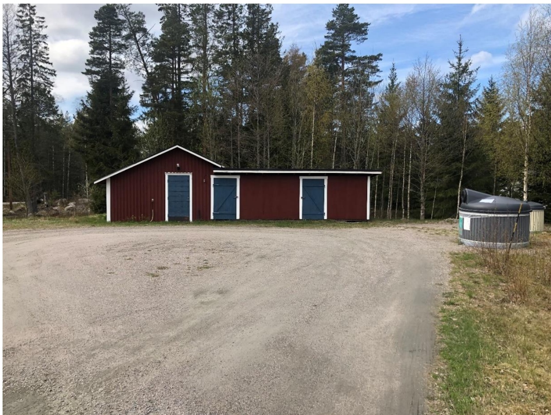
Befintlig teknisk anläggning och sopstation.
