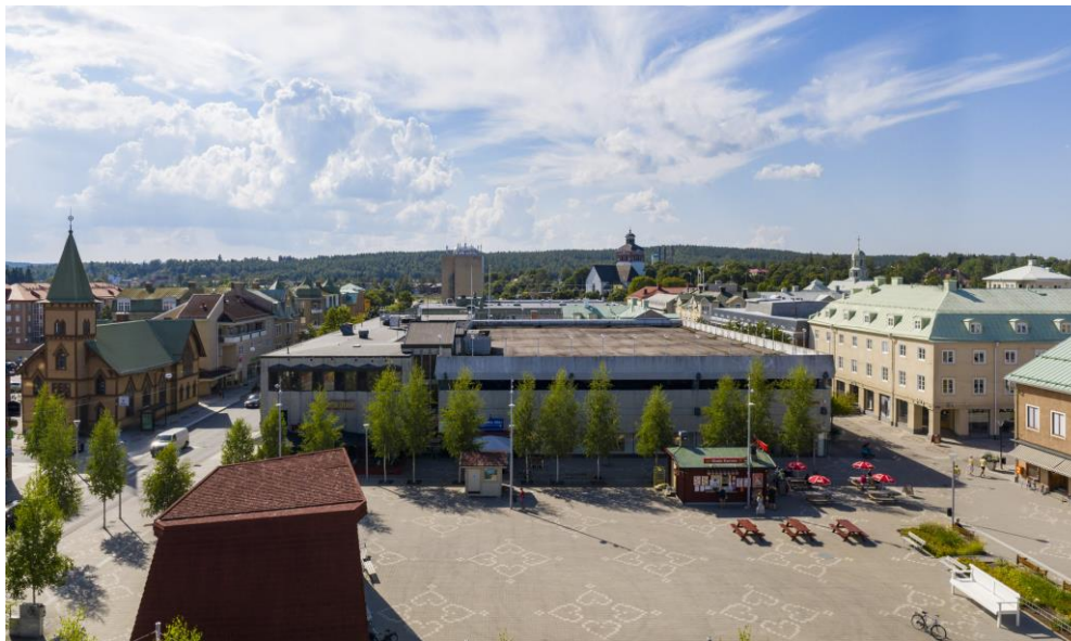
Bild på befintlig fastighet, vy från Brotorget. Källa: DREEM
