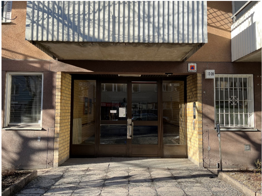
Entrén sett från Bondegatan (Reichmann antikvarier).
