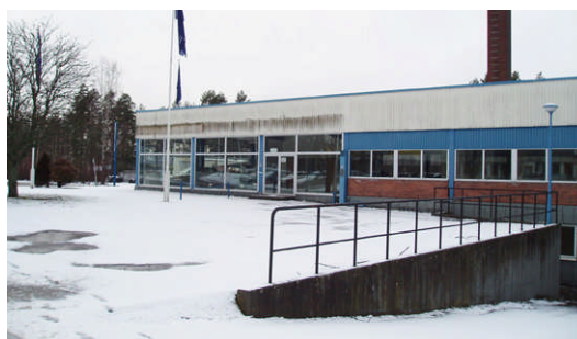
Byggnaden på fastigheten Röret 5.
