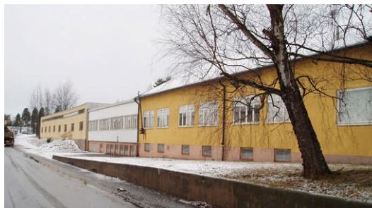
Röret 2 med sin stora byggnad som har byggts ut i etapper. Den äldsta delen närmast i bilden.
