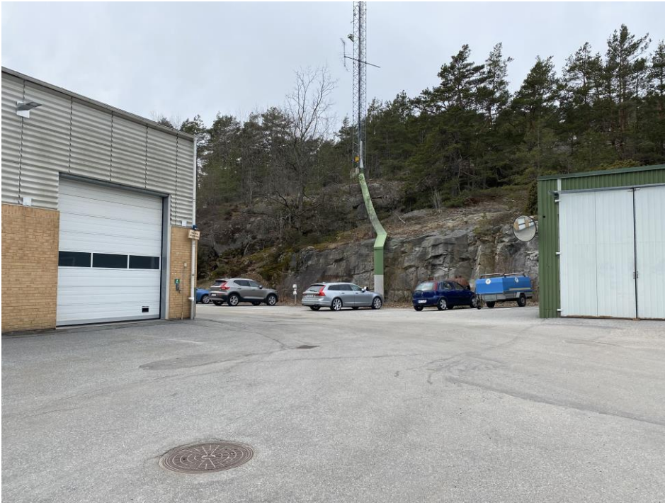
Figur 3. Hörnet av stationsbyggnaden med bristfällig sikt.
