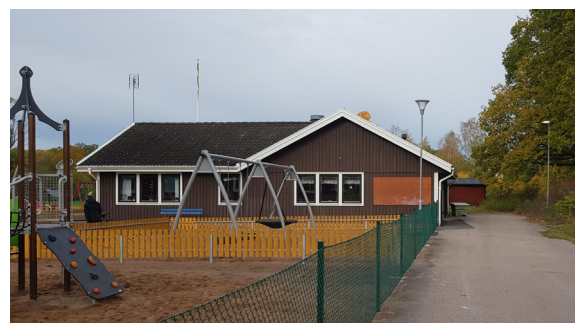
Bilden visar den äldre byggnaden med fritidshemsverksamhet som skall rivas.
