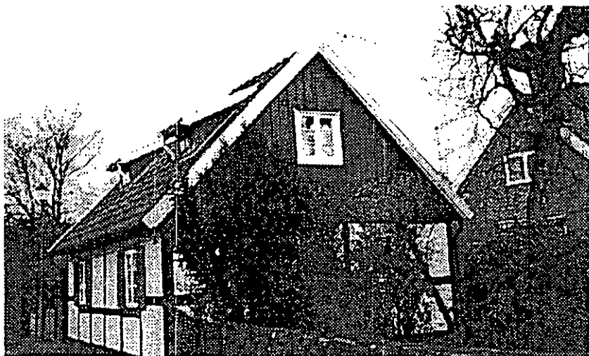
Fig.21; Pekpinnen5, korsvirkeshus utmed Bäckavägen
