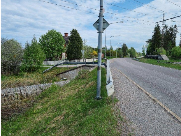
Figur 12. Vattentuben till Billerud där den passerar under Furuviksvägen.
