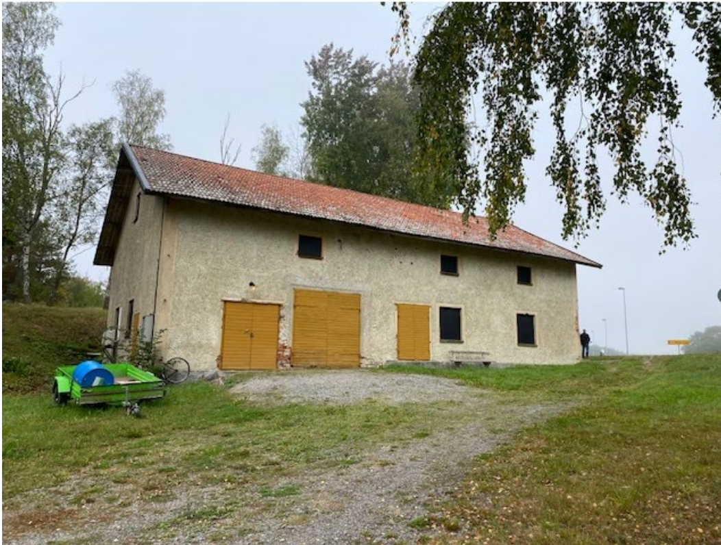
Förrådsbyggnaden som den ser ut idag.
