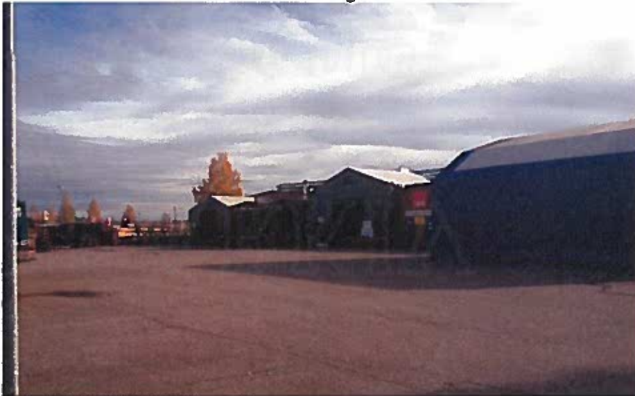
Vy befintlig byggnad från entresidan mot norr
