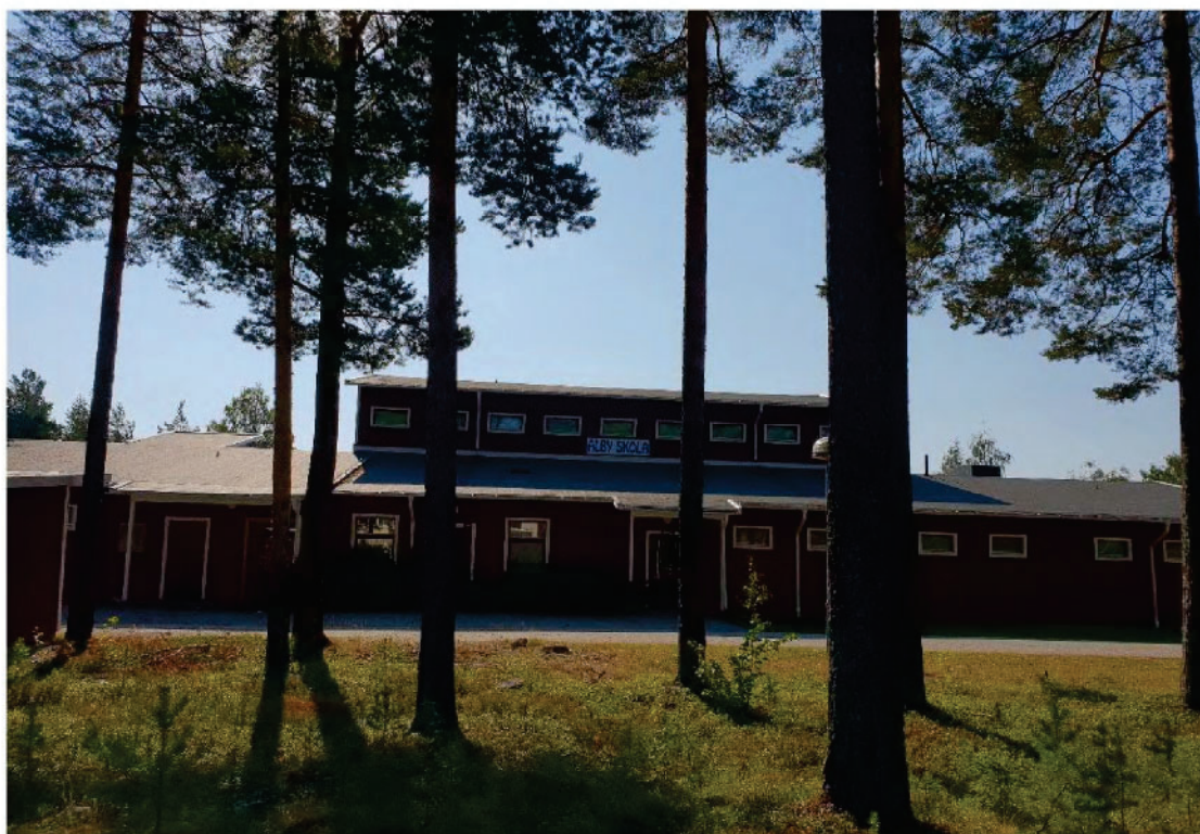
Figur 3. Huvudbyggnad på fastigheten Ovansjö 1:86.
