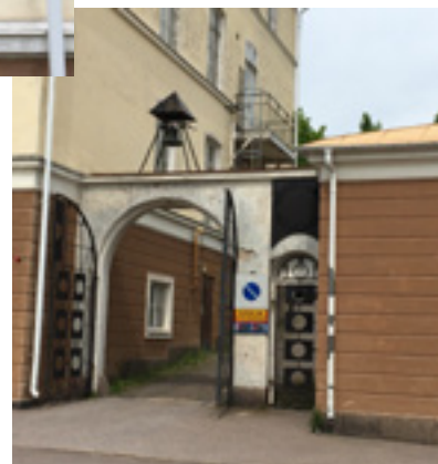
Port och del av portbyggnad
