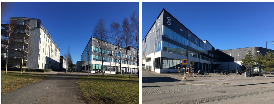
Befintlig bebyggelse i planområdets närhet, Aranäs etapp 2 och Aranäsgymnasiet.
