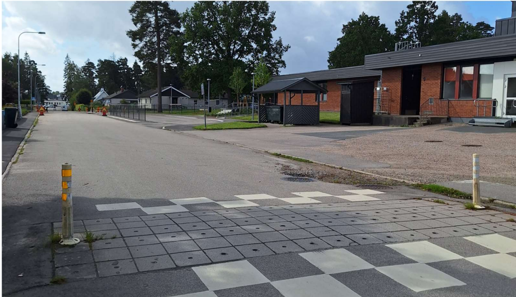
Björkstigen utanför Stensbergsskolan som visar trafikhindret samt av- och påstigningsplatsen till höger om gatan.
