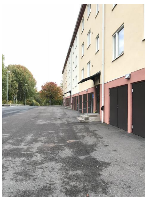
Vid Vretvägen, garage i bottenvåningen.
