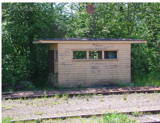
Våghuset i bangårdens södra del.
