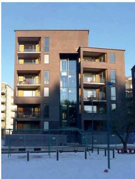
Exempel på sammanhållna och utåtblickande volymer. Projektet visar även exempel på hur balkonger kan gestaltats med omsorg och tydligt inarbetats i byggnadens utformning och helhetsuttryck.
