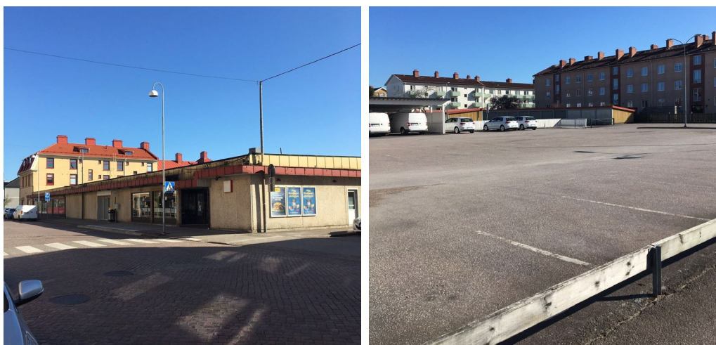
Figur 4. T.v. Mot Skaragatan finns tidigare butik i en våning. T.h. Tillhörande markparkering.
