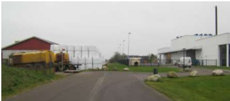
Infartsväg till aktuell verksamhet samt allmän platsmark för lokalgata som aldrig har blivit byggd.
