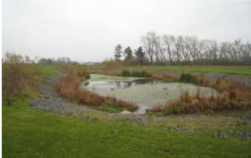
Dagvattenmagasinet på naturmark
