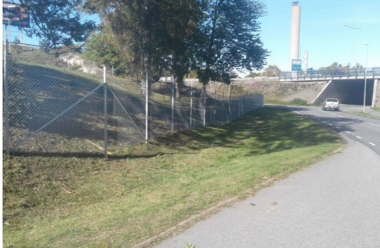
Bild 4. Den befintliga slänten mot E4/E20.
