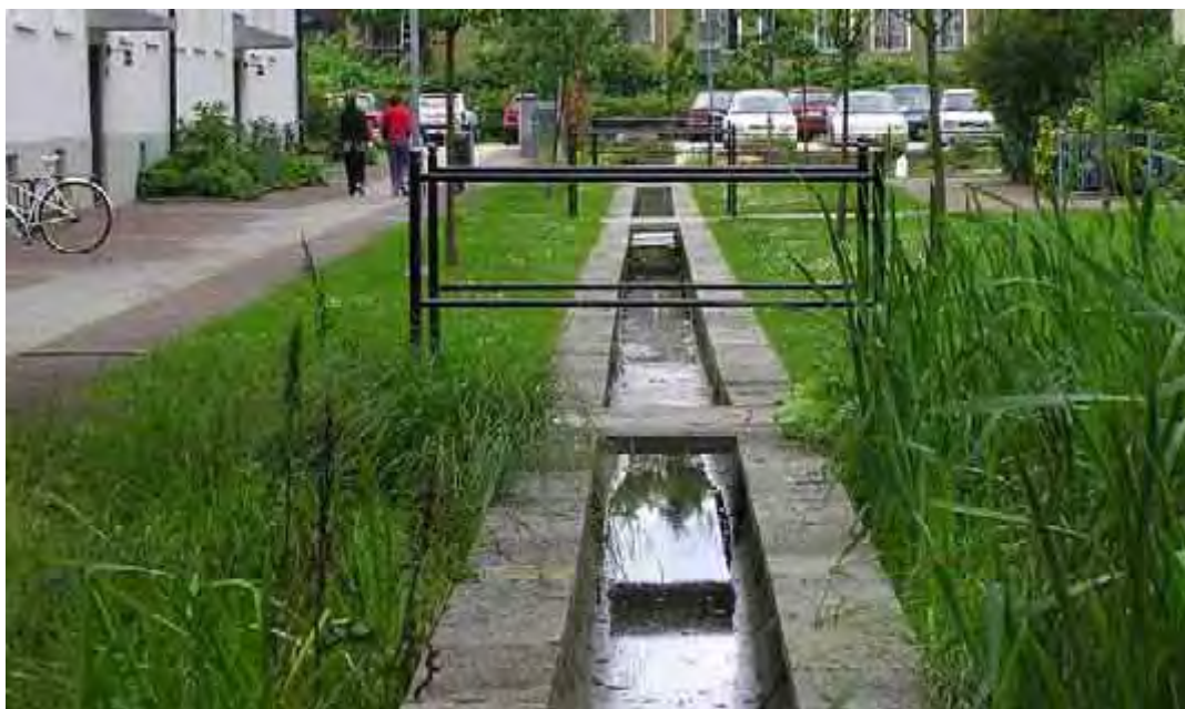
Exempel på öppen kulvert som kan leda dagvatten till fördröjningsyta väster om Mariebergsskolan, förslagsvis inom yta b 3 i plankartan.
