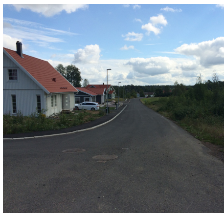
Björkebacksvägen med första etappen till vänster. Etapp II kommer bebyggas till höger om vägen.
