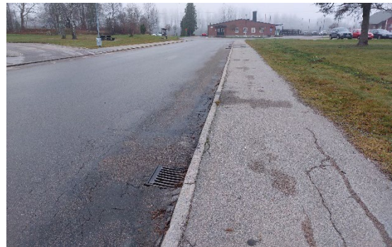
Dagvattenbrunn vid lågpunkten på Stationsgatan.
