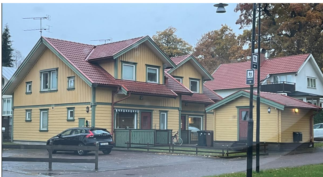
Figur 8: Bilden visar befintlig fastighet.
