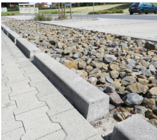
Bild 39: Makadamdike till vänster och prinsipskiss av magasin med fliter till höger. Bilderna är hämtade från Svenskt Vatten Utveckling, Rapport nr 2019-2020.
