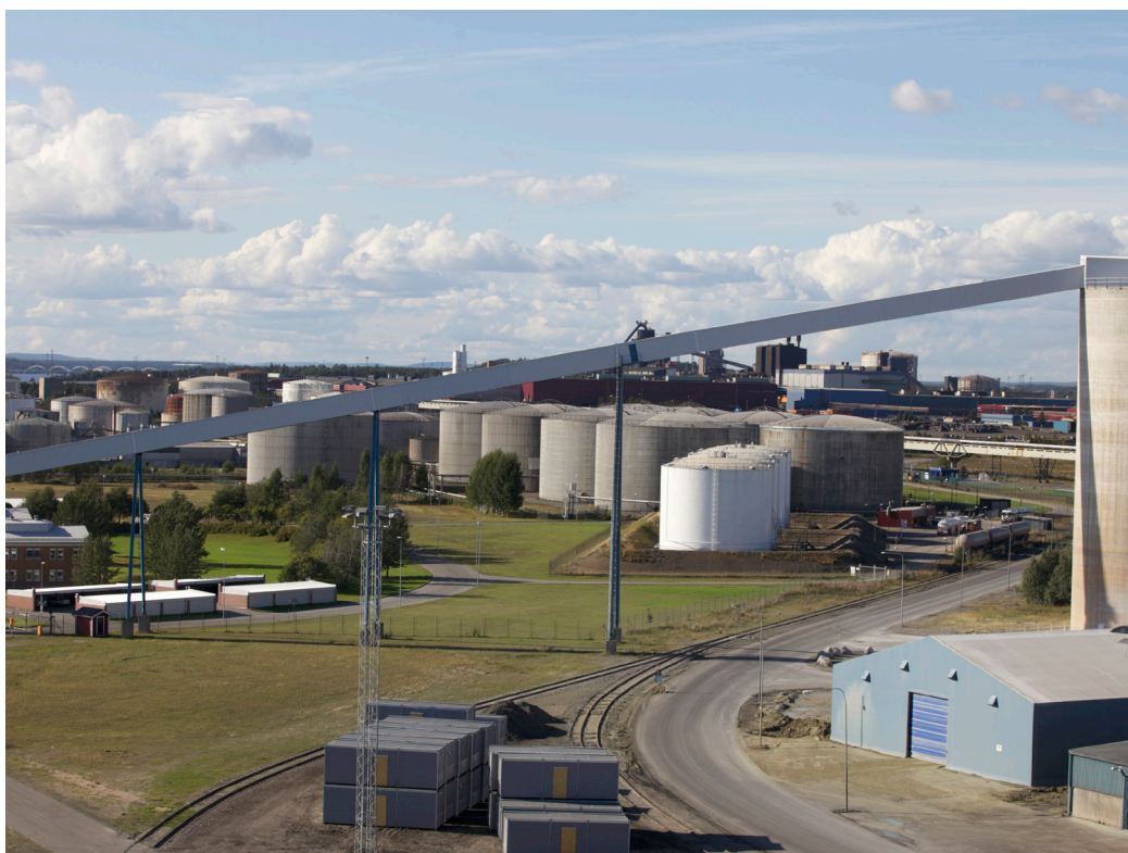
Bild 24: Bilden visar vy över Victoriahamnen med stålverket som syns i bakgrunden. (Luleå kommun)
