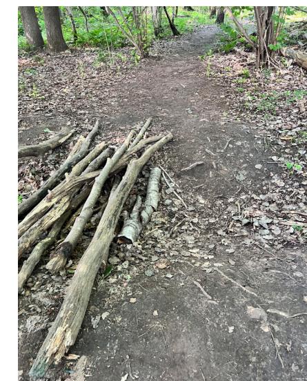
Överbyggnad över dike.
