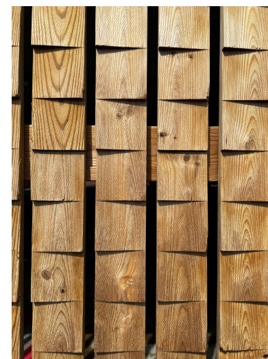
Träklädda fasader i P-hus Svanen, Norrköping. Ark Kai Wartiainen Foto: Johan Nylind
