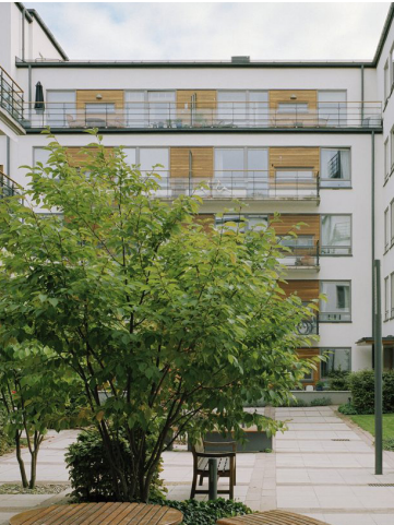
Referensbild exempel på träinslag vid balkonger.
