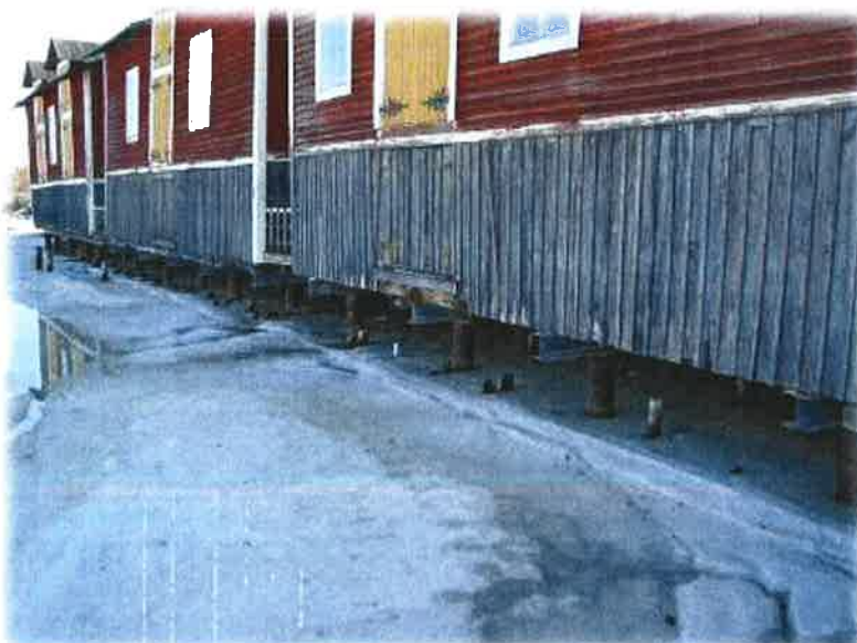
Pålar och järnbalkar som håller upp Saltmagasinen
