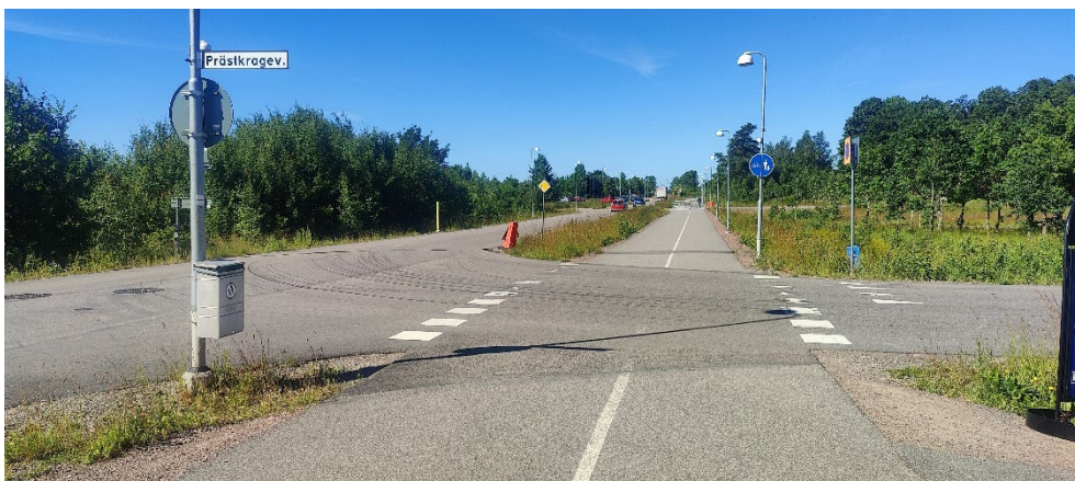
Värnsnäs vägen vid korsningen med Prästkrogevägen med blick mot Norra vägen
