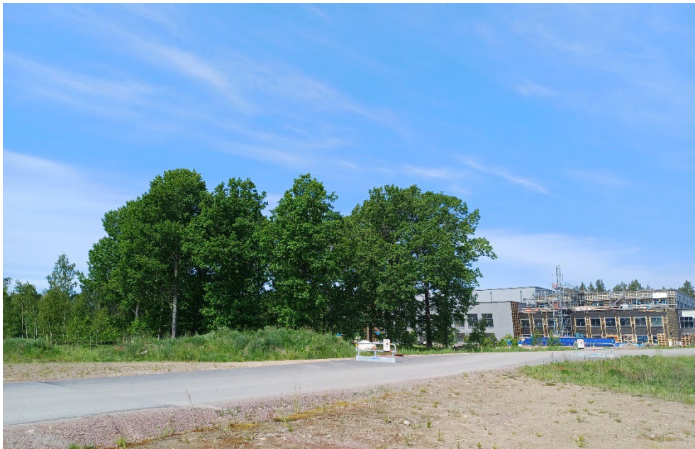
Träddungen i området tillsammans med pågående byggnation av bad- och friskvårdsanläggningen i bakgrunden.
