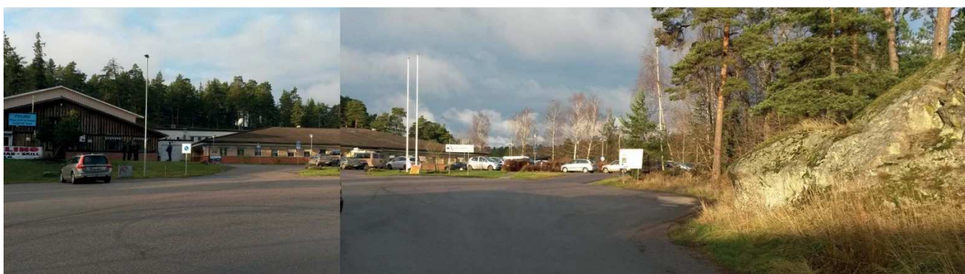
Fastigheten idag med kontors- och lagerlokaler.
