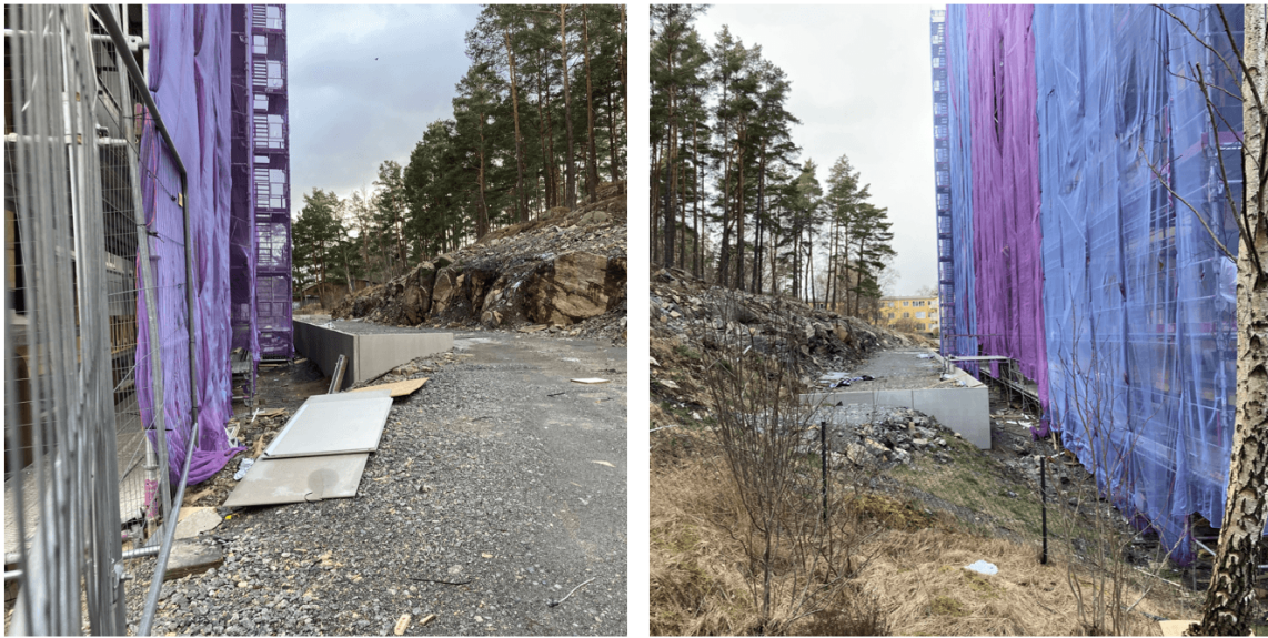
Figur 2: Bergslänt väster om flerbostadshuset. Foto: Göteborgs Stad
