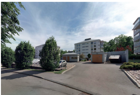
Befintligt garage på kv Vadden sett mot öster. Bilden visar infarten till parkeringen som är ovanför det nedgrävda garaget.
