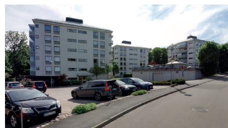
Bilden visar de befintliga punkthusen inom kv Vadden, sett från Falkvägen mot söder.
