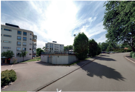
Befintligt garage på kv Vadden sett mot väster. Bilden visar infarten till den del av garaget som är belägen under mark.
