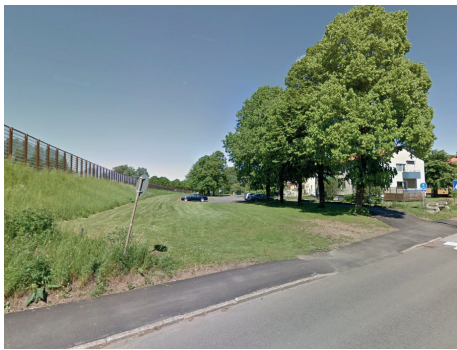
Gräsytan där skyfallsleden är tänkt att gå. Alléträden kommer inte tas bort.
