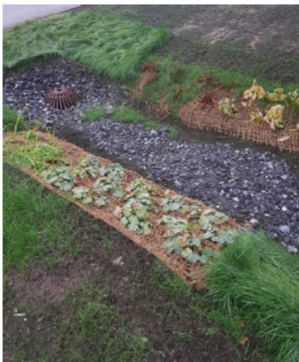
Exempel på makadamdike med kupolbrunn i Luleå. (Afry, 2024-01-31)
