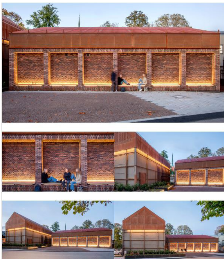
Inbyggt ställverk i Växjö, kv. Elverket - Inspirationsbild
