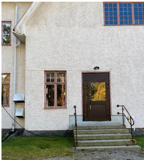
Figur 2: Fönster och fasad
