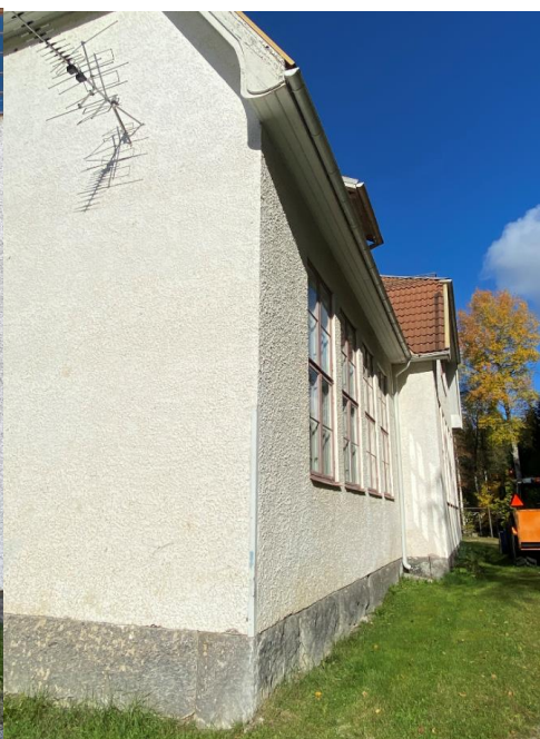
Figur 3: Fasad och sockelparti
