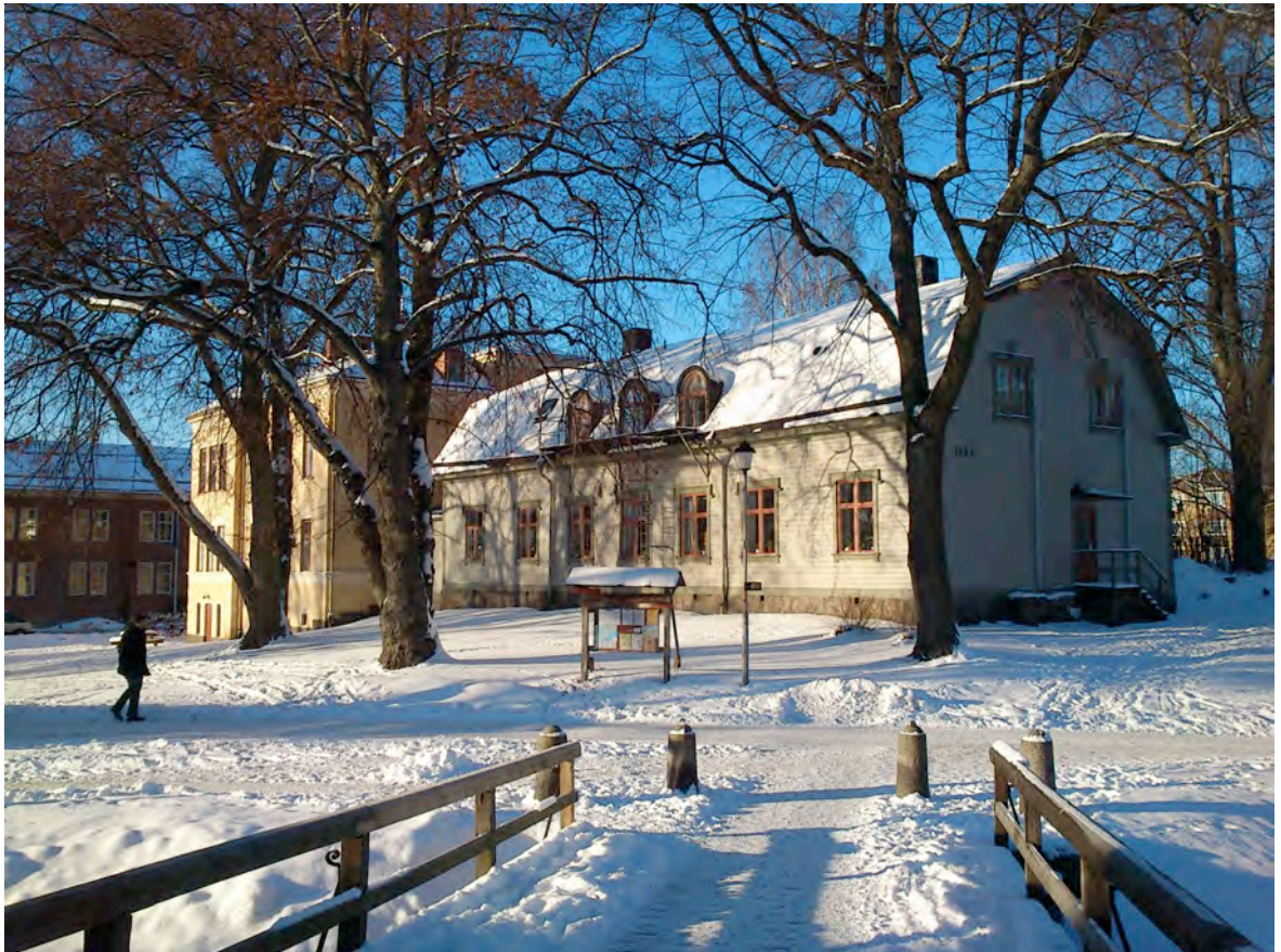
Vandrarhemmet och f.d. skolhuset sett från Nyköpingshus.
