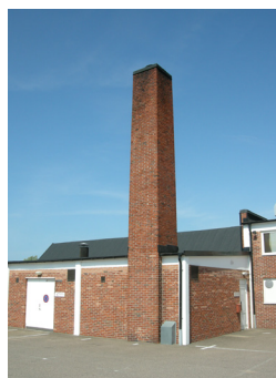
Den murade skorstenen på Lejonet 10.
