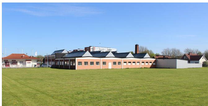
Sågtandstak och perspektivfönster på Lejonet 10.
