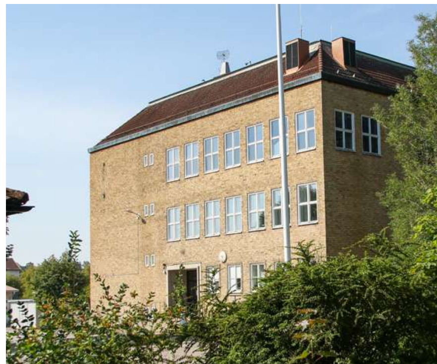
Befintlig tegelbyggnad. Släbroskolan, Nyköpings kommun
