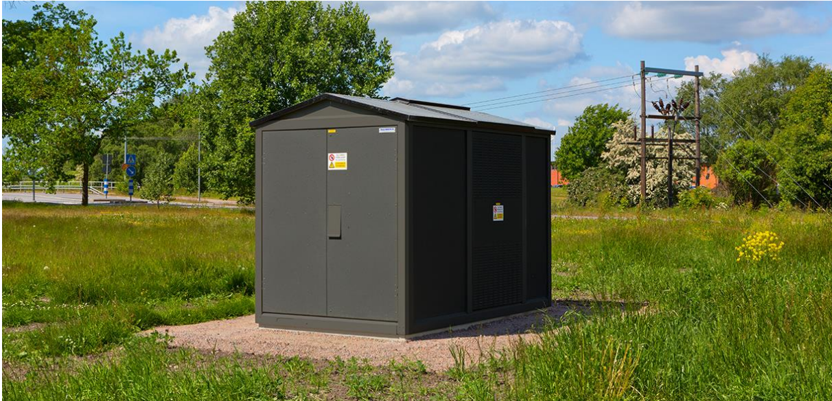
En typisk nätstation i plåt.
