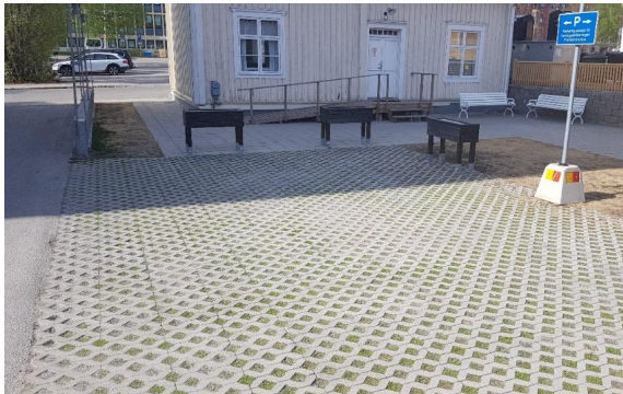
Så kallat armerat gräs eller betonggräs. Ett exempel på en genomsläpplig parkeringsyta som bidrar till infiltration och rening av dagvatten. (AFRY, 2022-11-28)
