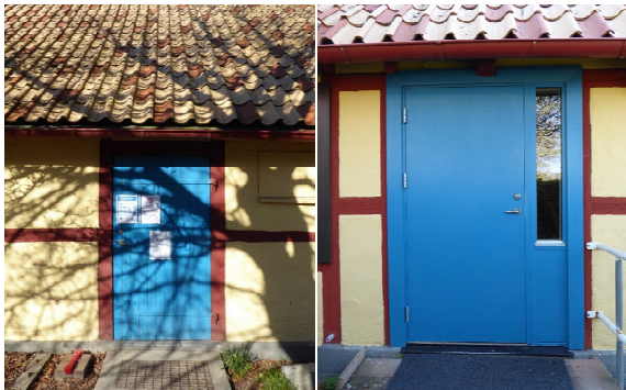
Moderna dörrar på östra och västra fasaden.
