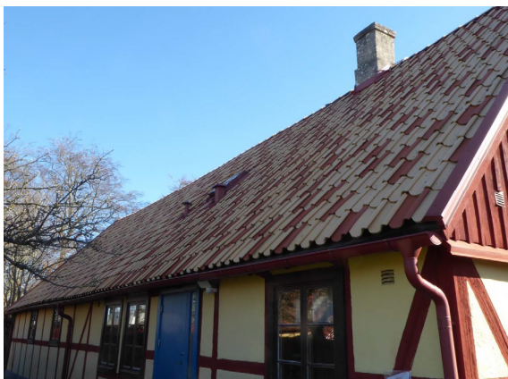
Enkupiga tegelpannor, skorsten inock och modern avvattning.
