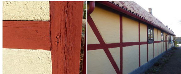
Korsvirkesfasader med sågat virke och rak timra.
