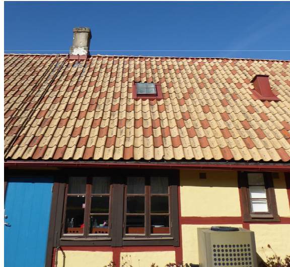
Putsad skorsten inock. Mindre takfönster.
