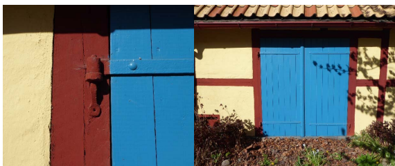
Dörr och dubbelport på den östra fasaden. Äldre hakgångjärn.
