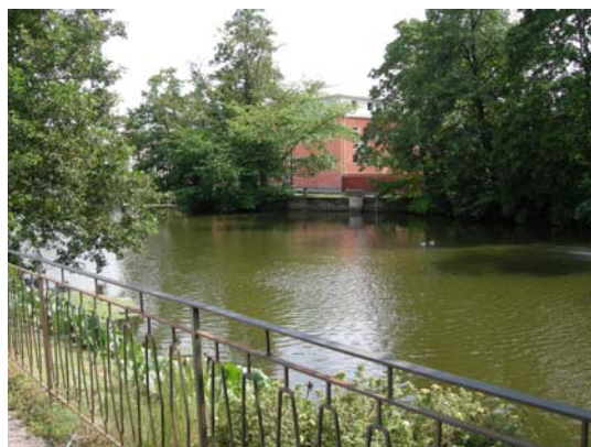
Befintlig strandskoning och skyddsräcke
