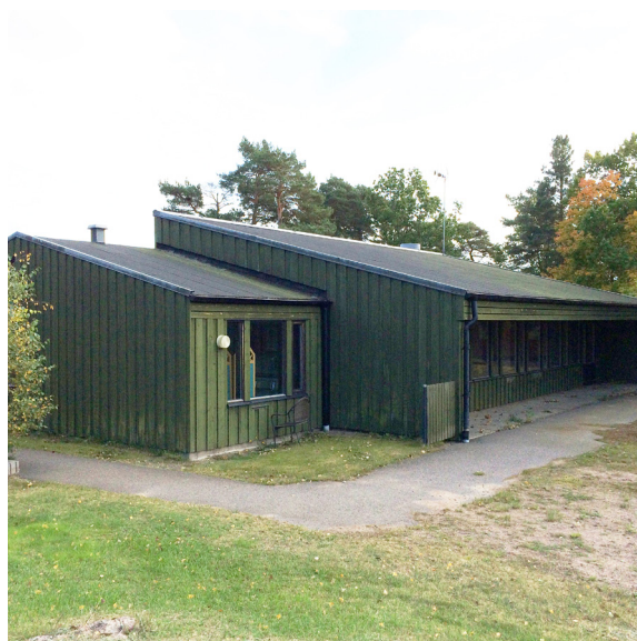
Bild 3. Tallar avses bevaras bakom byggnaden.
