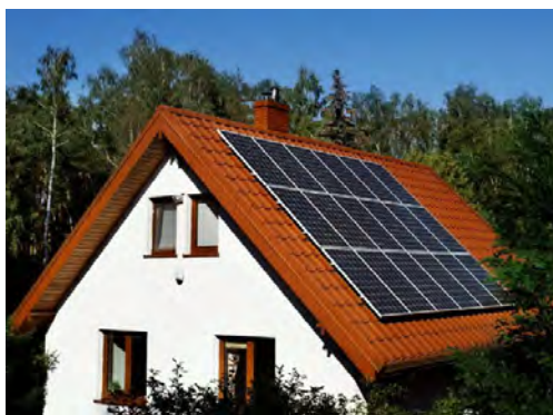
Exempel på utanpåliggande solenergianläggning.
