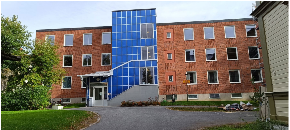
Figur 12: Kontorsbyggnaden på fastigheten Stadspredikanten 1.
