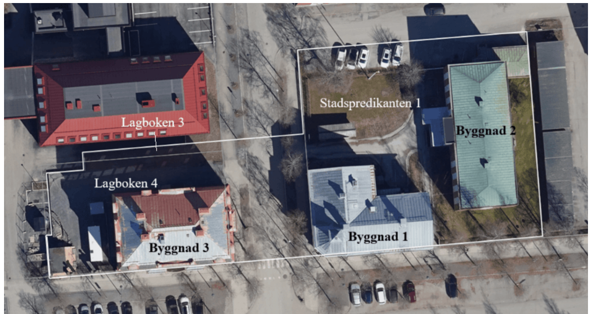
Figur 3: Befintliga byggnader inom planområdet.
