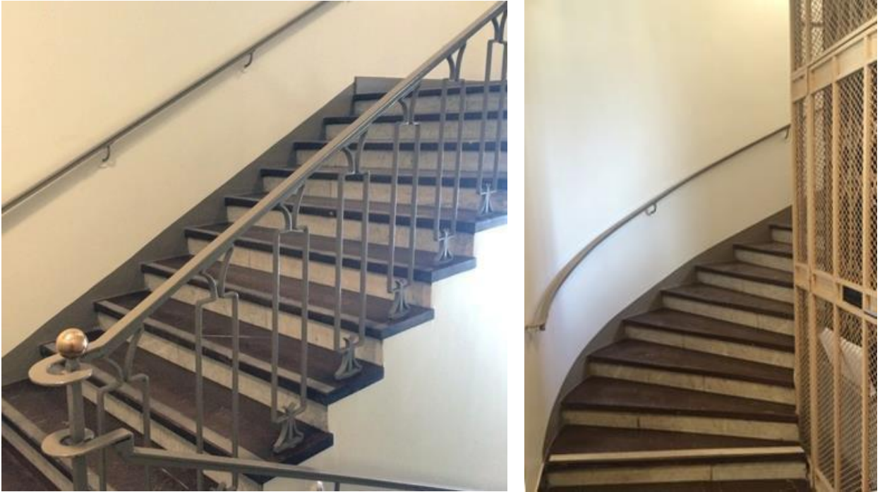
Trapphusets smidesräcke samt stenbeläggning
