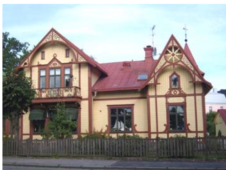
Huvudbyggnad. Fasad mot Teatergatan.
