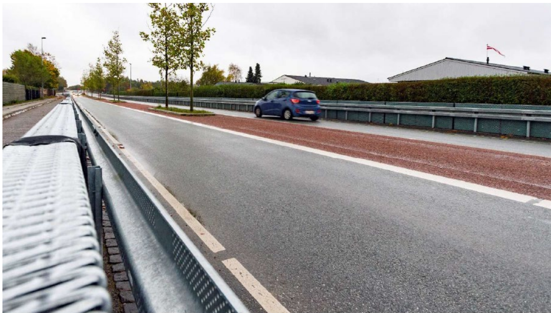
Bilden visar bullerskydd monterat i vägräcke i Billund, Danmark. Källa: Trafikbullerutredning Östra Kasern 3, Kristianstad, Efterklang 22-05-09.
