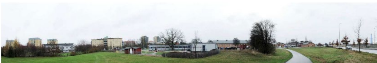
Panorama över planområdet med vy från cykelvägen vid Vattentornsvägen. Befintlig bebyggelse inom planområdet utgörs av två förskolor, t.v. Allö förskola i två våningar, t.h. Parks förskola i tillfällig paviljongbebyggelse
