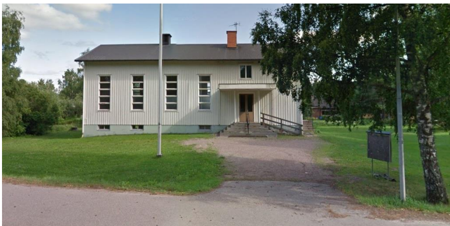
Figur 5: Befintlig byggnad inom planområdet
