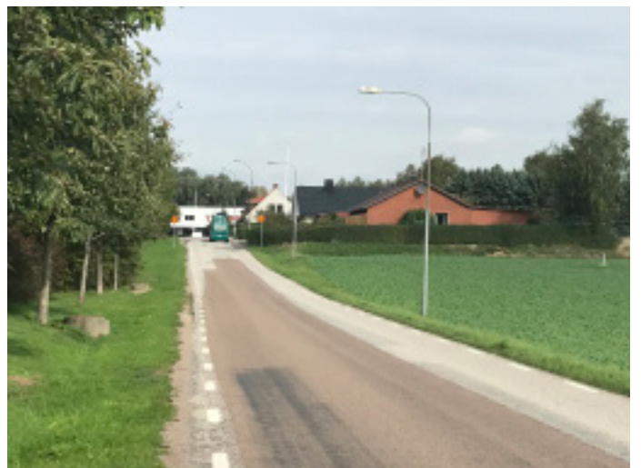
Bild tagen på Åbyvägen mot norr.
