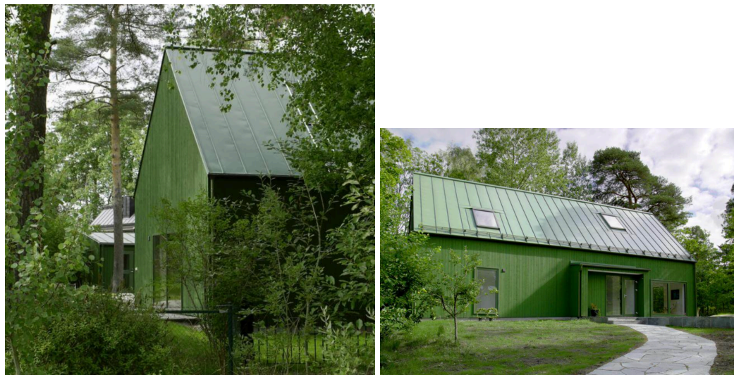
Figur 29. Exempel på grön kulör på fasad och tak som får byggnaden att smälta in i omgivningen (Byggahus.se, 2014).
