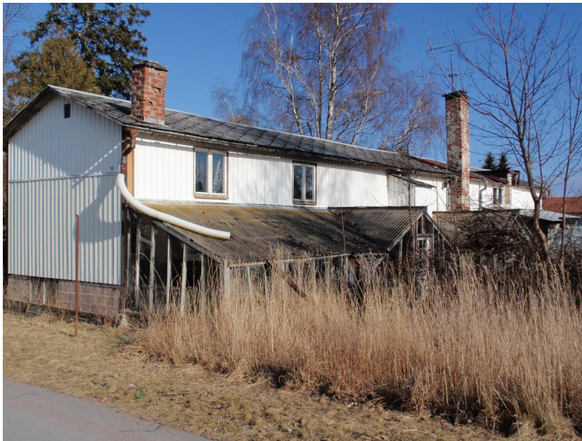
Befintlig byggnad med bostadshus och växthus som ska rivas
