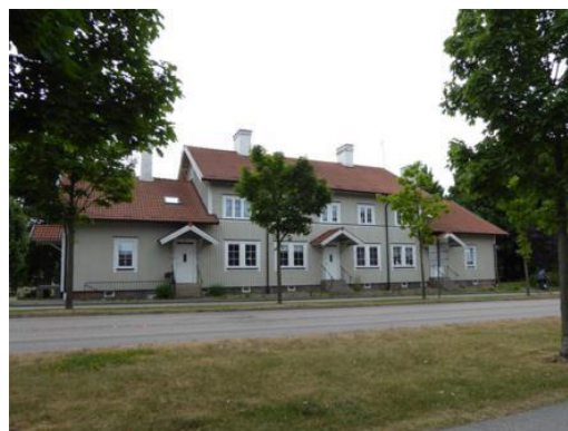
Byggnaden idag "Kärringträtan" sedd från Kristianstadvägen.
